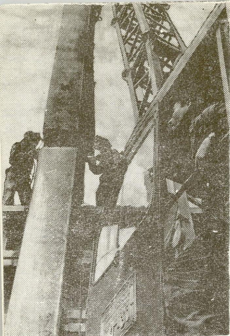
Строится вторая очередь производства карбамида.
