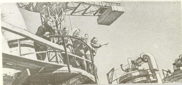
Бригада изолировщиков Ф. Сайдашевой на сооружении производства аммиака.
