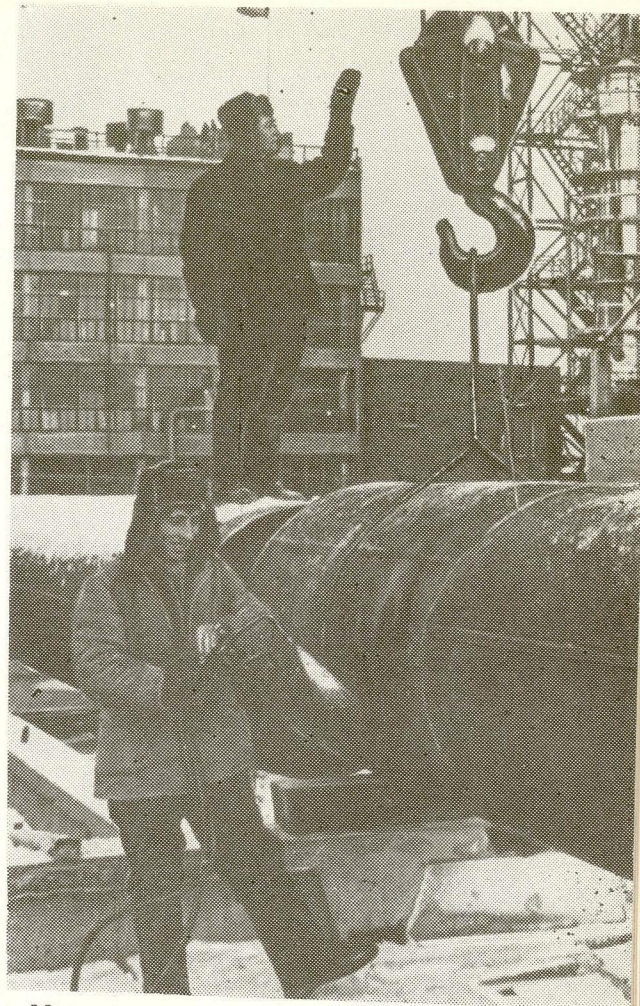
Монтажники на одном из объектов нефтехимического комбината,
